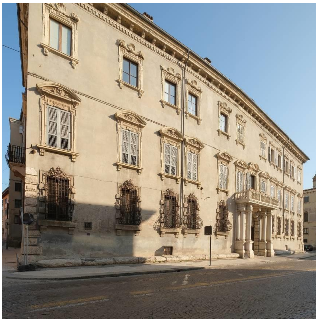
32 - Palazzo Carlotti, su Corso di Castelvecchio (odierno Corso Cavour 2) a Verona.
