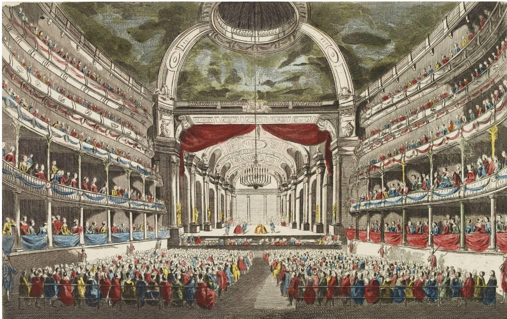
79 - Il Teatro Filarmonico di Verona, come si presentava dopo la prima ricostruzione, a seguito dell'incendio del 1749, ricostruzione terminata nel 1753. È questo il teatro del tempo delle Pasque Veronesi , del Congresso di Verona del 1822 e, prima ancora, quello in cui le autorità veneziane offrirono uno spettacolo in onore di Bonaparte e di Giuseppina Beauharnais, il 22 ottobre 1796. Ben prima dell'insurrezione di Verona contro il despota còrso. Stampa francese del 1780 circa.
